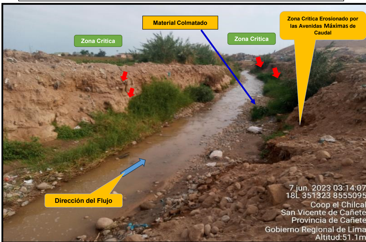
FIGURA N°03: ZONA CRITICA EROSIONADO DE LAS AVENIDAS MAXIMAS DE CAUDAL, PRODUCIDO POR FENOMENOS NATURALES COMO EL NIÑO COSTERO O EL CICLON YAKU.
