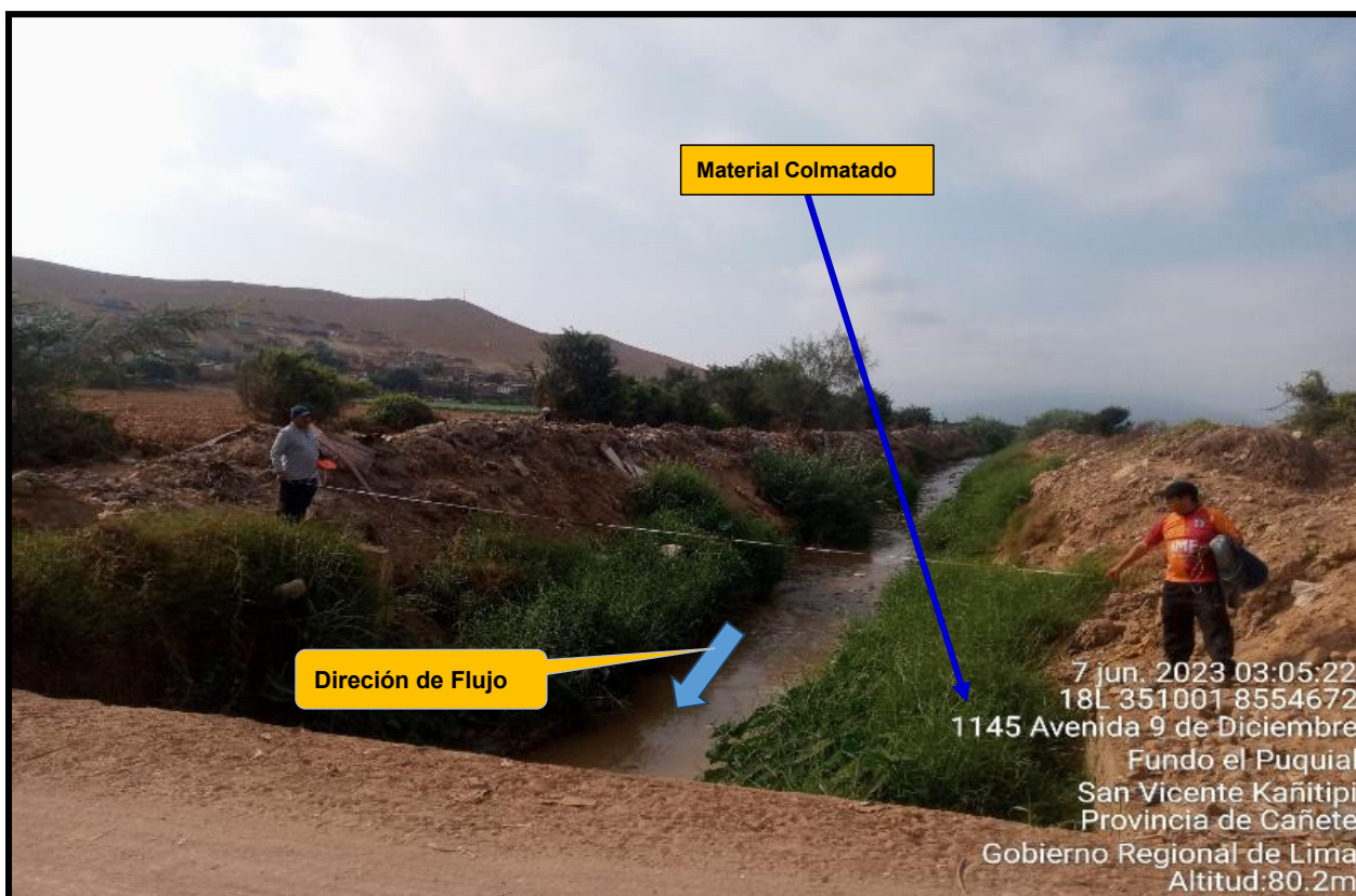
FIGURA N°05: : MEDIDA DEL ANCHO DEL FINAL DEL PUNTO CRITICO DE LA QUEBRADA POCOTO DEL SECTOR CERRO ALEGRE - CHILCAL, EN ESTA PARTE EL CANAL ESTA COLMATADO DE MATERIAL DE DESMONTE.
